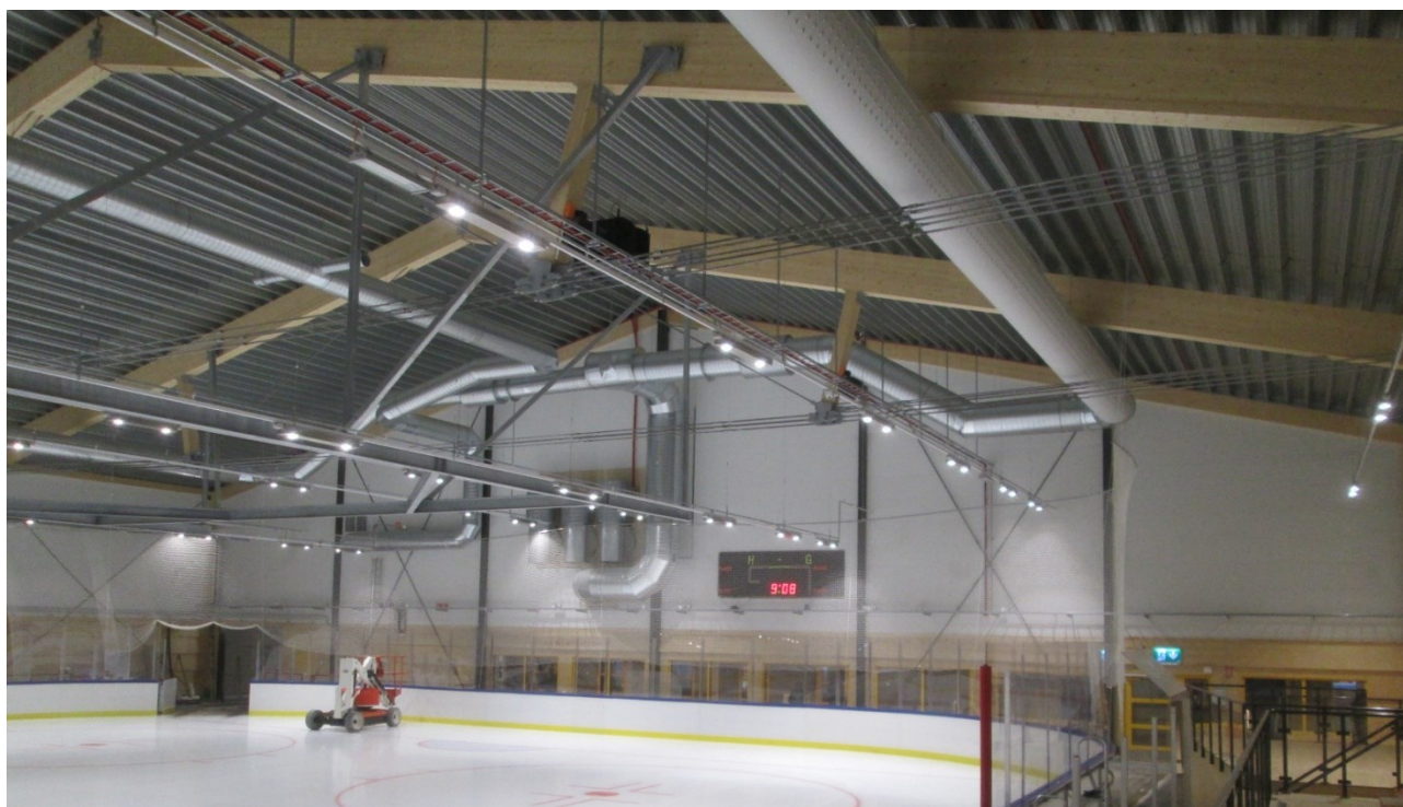
Figur 13. Ventilationsfunktionens distributionssystem i en ishall.
