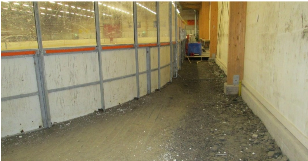
Figur 9. Gruspist där även omgivande ytor i ishallen helt eller delvis är "öppna", dvs de har inget täckskikt.
