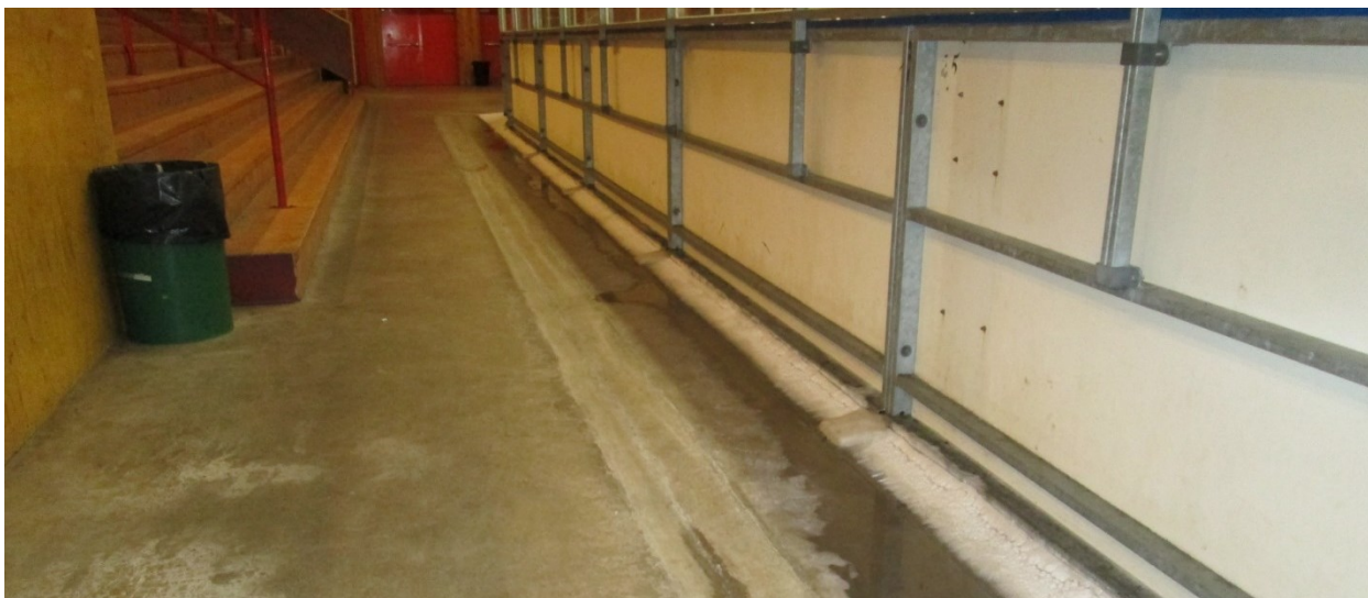
Figur 8. Dräneringsränna utanför ispisten för att hantera smältvatten.
